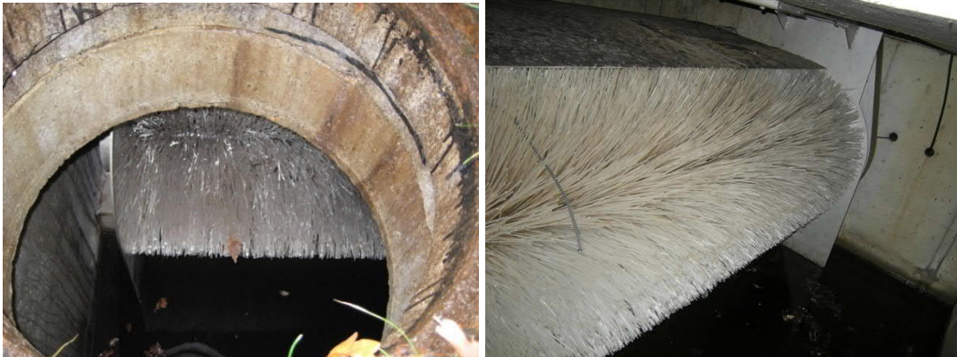
Figuur 7-2: Borstels in riolering gemeente Dalfsen
